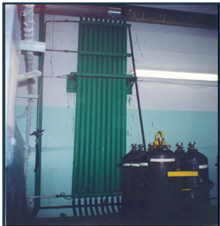
Рис. 4. Фильтры очистки газообразной \text{CO}_2
