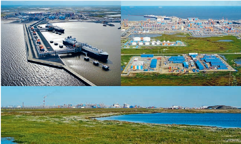
Рис. 4. Загрузка 20-миллионной тонны СПГ в газозов «Владимир Воронин» в порту Сабетта (вид из вертолета) и панорамная фотография завода «Ямал СПГ» (фото В.И. Богоявленского, 14 августа 2019 г.)
