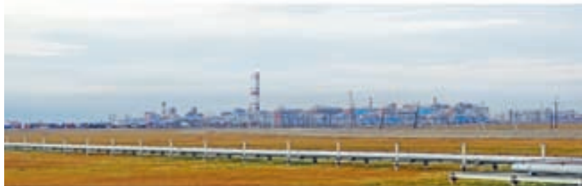
Рис. 4. Завод «Ямал СПГ» в Сабетте (фото авторов 29.08.2017)
