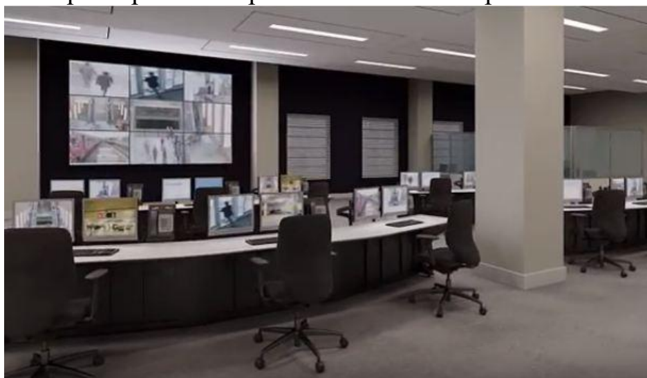
Рис. 3.6. Ситуационный центр мониторинга и управления чрезвычайными ситуациями (ЦЧС) РЖД
